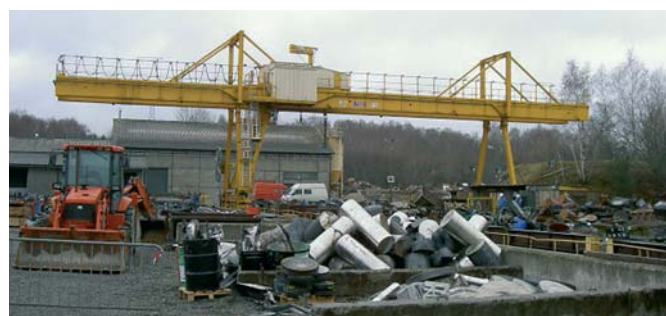
Vue générale du chantier.
