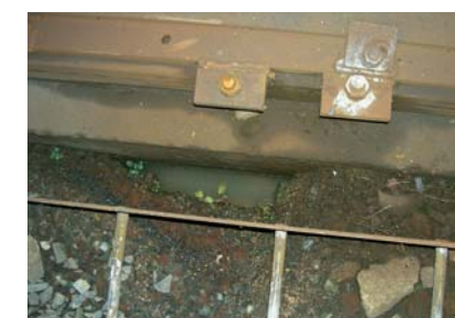
Affouillement provoqué par les intempéries.
