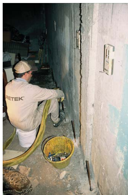
Injection de la résine effectuée sous contrôle laser depuis les caves.
