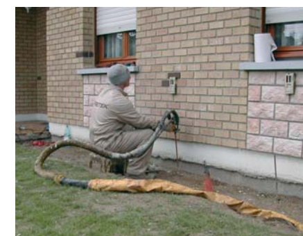
Injection de la résine Uretek le long de la façade avant.
