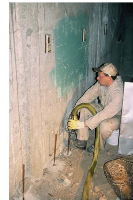
Certaines injections ont été réalisées en passes alternées.
