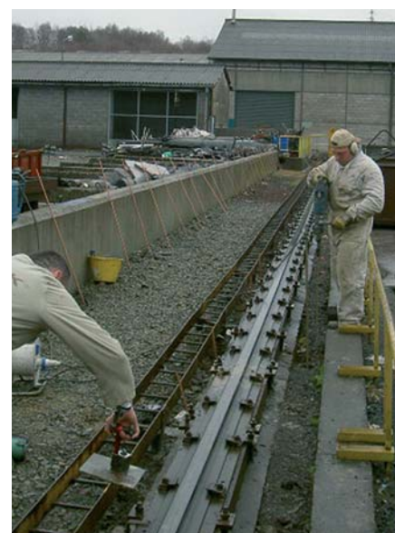
Mise en place des tuyaux d'injection de la résine Uretek.
