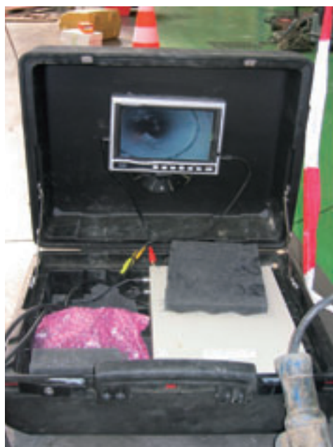
Contrôle continu des réseaux pendant l'injection
