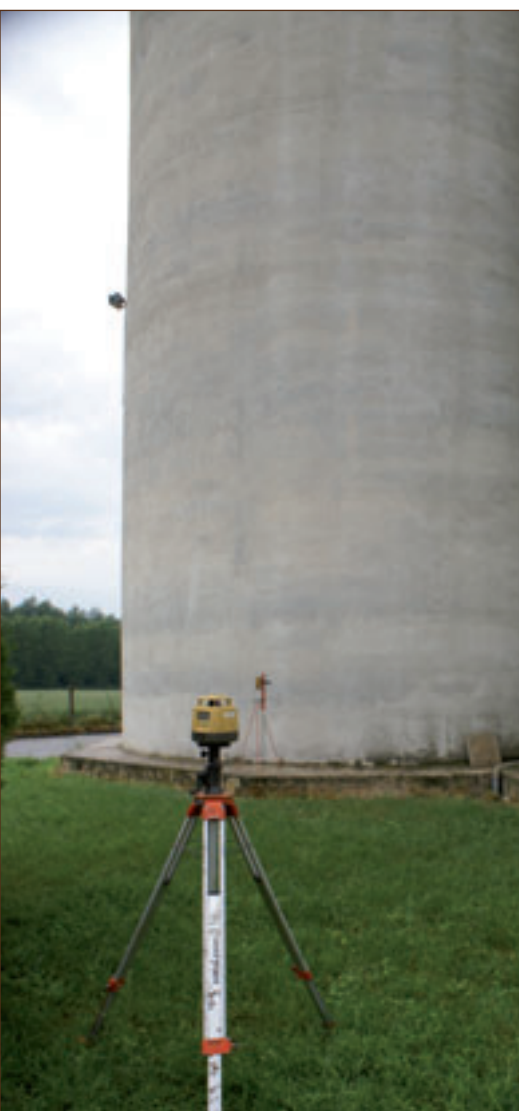
Silo sous contrôle laser
