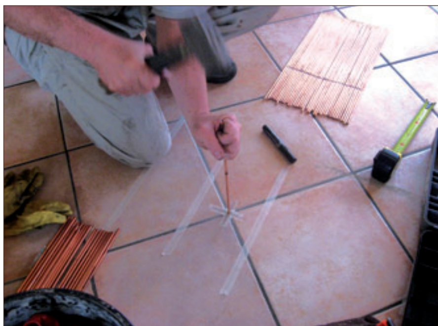
Implantation précise d'un tube d'injection
