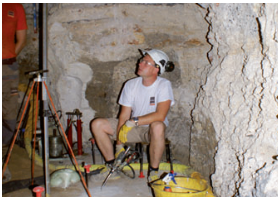
Intervention depuis les sous-sols du bâtiment
