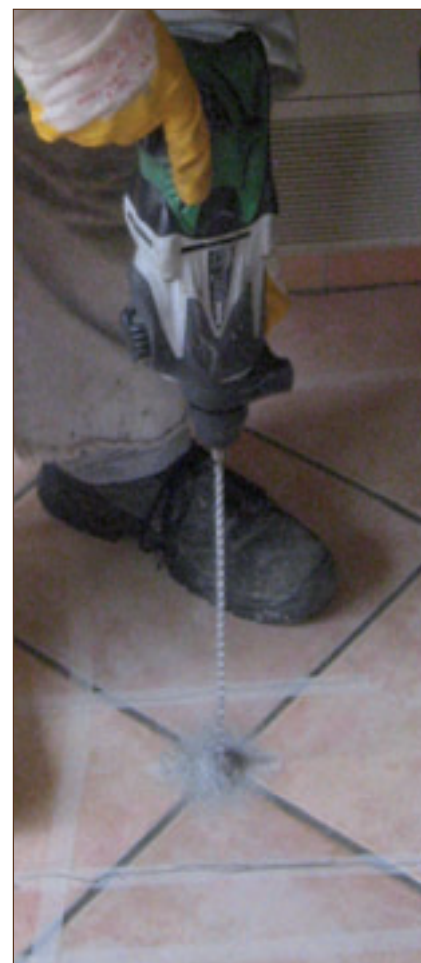
Percement pour tuyau d'injection
