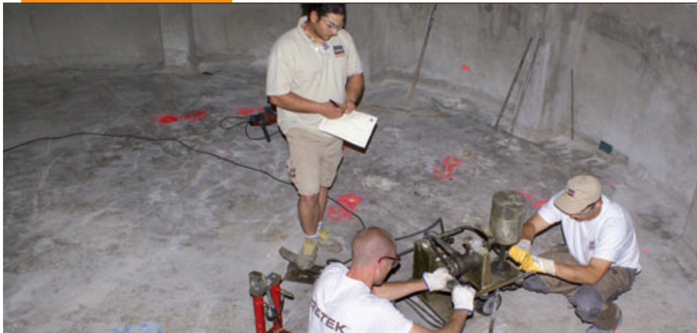
Réalisation d'un test pénétrométrique dynamique
