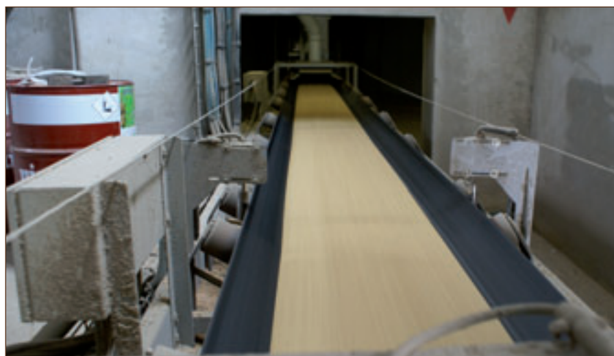
Pas d'interruption d'activité pendant les travaux
