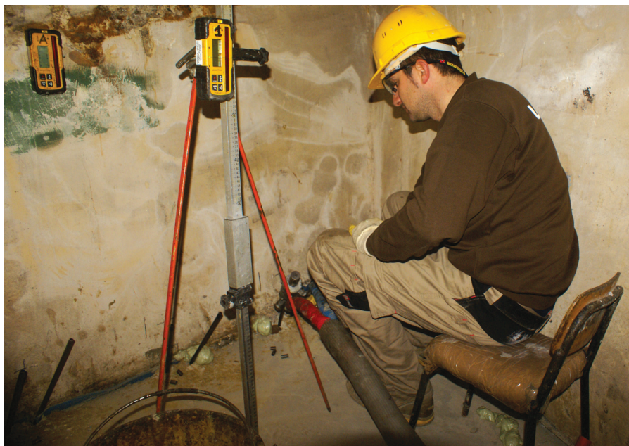
Travaux sous contrôle laser permanent en espace confiné
