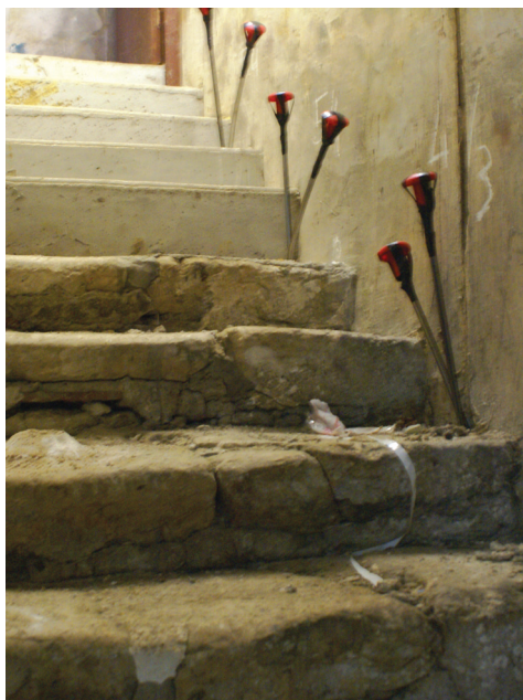
L'escalier n'est pas un obstacle au traitement de sol en profondeur
