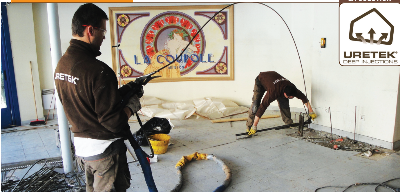
Travaux d'injection de résine expansive à l'intérieur du bâtiment
