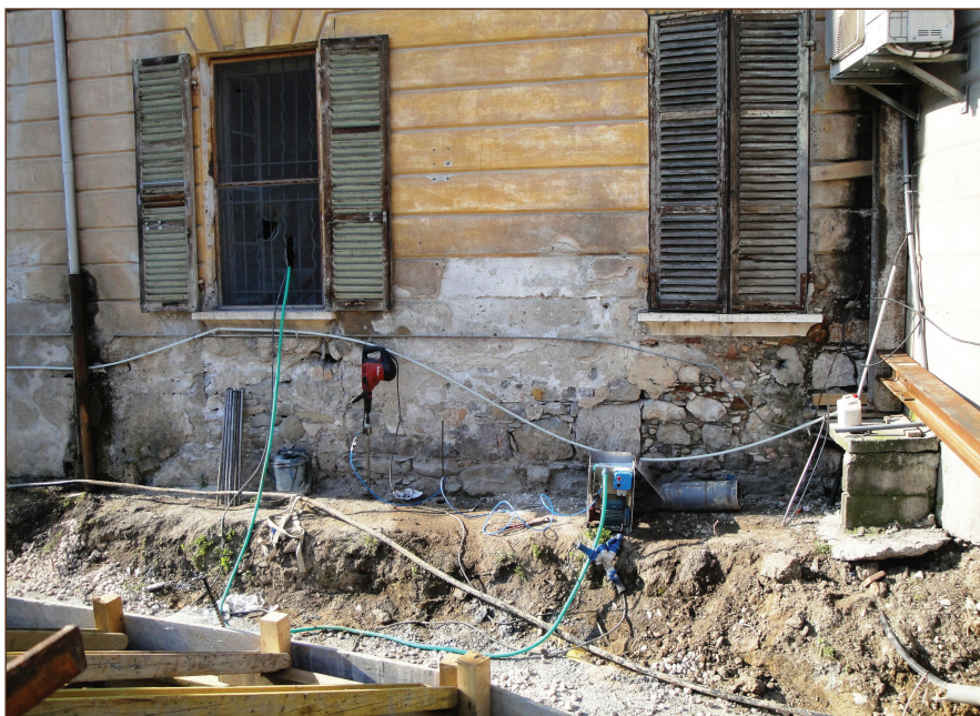
Travaux d'injection entre l'immeuble et la paroi moulée
