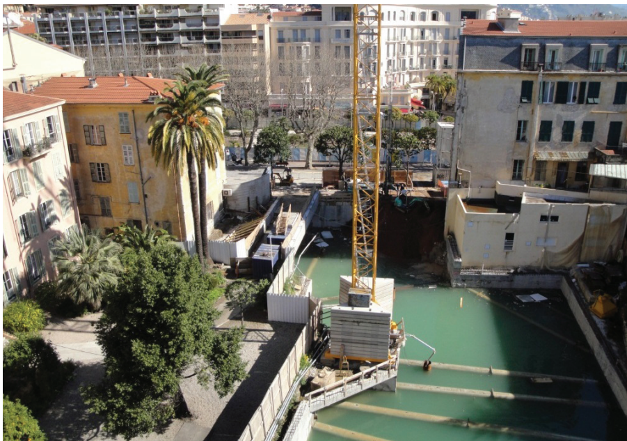
Vue d'ensemble des travaux de construction, zone d'excavation inondée
