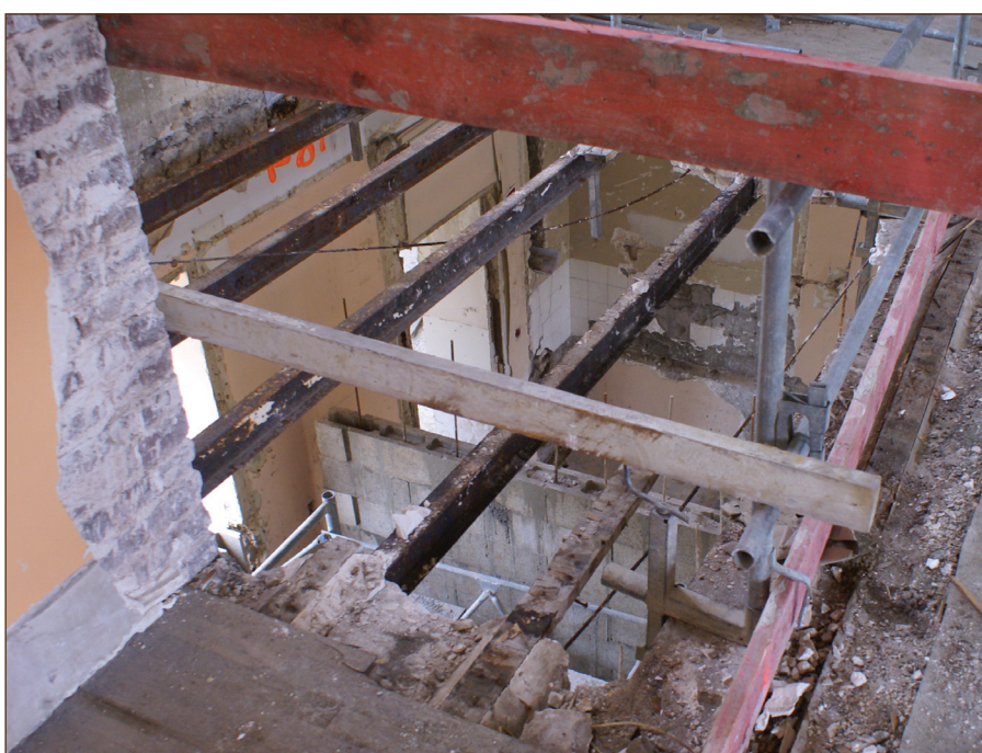
La descente de charge a été modifiée par la réalisation de nouveaux planchers
