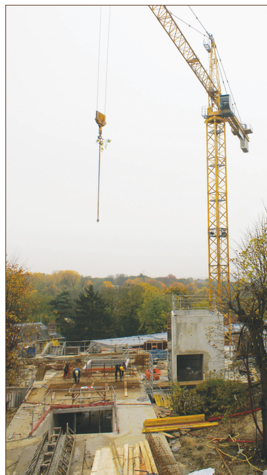
Des travaux en co-activité
