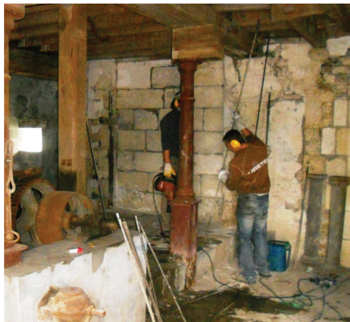
Phase d'introduction des tubes d'injection depuis l'intérieur de la vieille bâtisse
