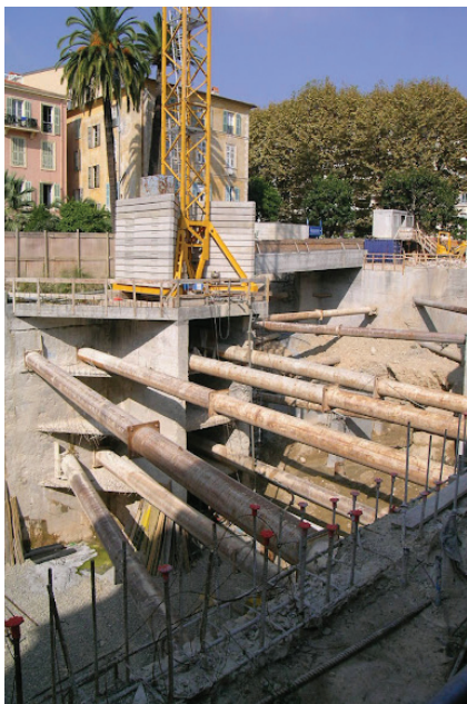
Terrassement et parois moulées
