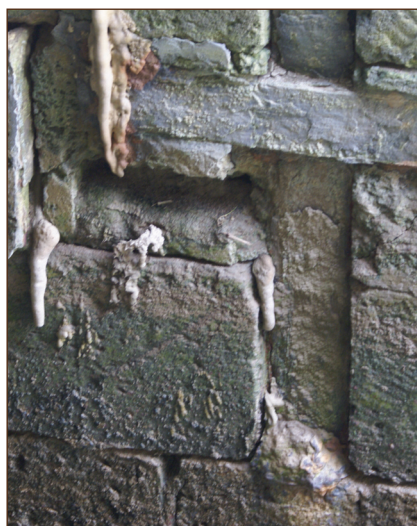
Détail de la pénétration de la résine dans le mur en milieu immergé
