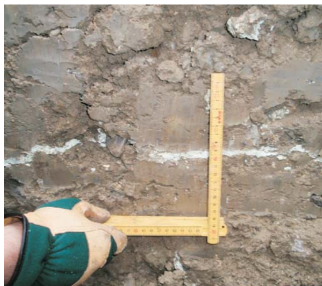
Pénétration de la résine par remplissage des fissures de retrait et compactage
