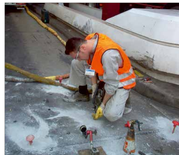
Réalisation des injections de résine expansive
