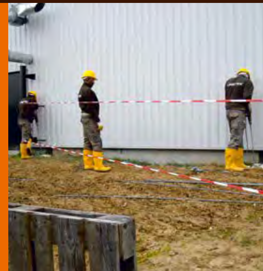
Le percement des trous pour placer les tubes d'injection.
