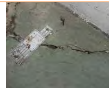
Une des nombreuses fissures sur le dallage de l'entrepôt.
