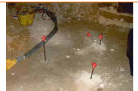
Les tubes d'injections en attente.
