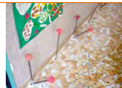
Injections réalisées au niveau des murs porteurs.
