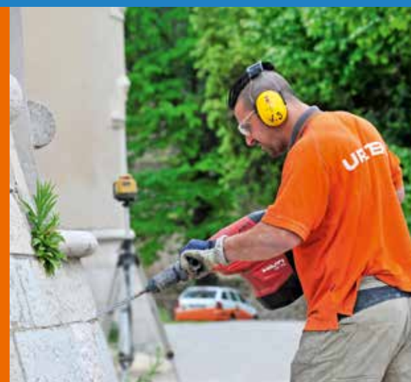
Perforation des trous dans la maçonnerie.
