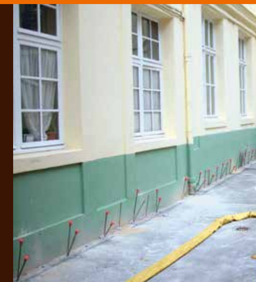
Les tubes d'injections placés dans la cour de récréation, permettant d'atteindre les fondations.
