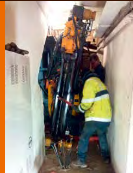
La foreuse permettant d'atteindre 15 m de profondeur.
