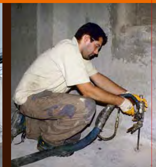
L'injection de résine expansive sous radier, à l'intérieur d'une cellule.
