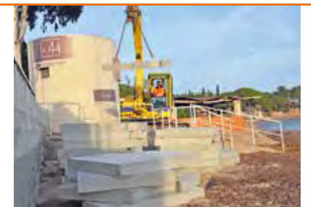
Mur para-fouille mis en place par la société GTS.
