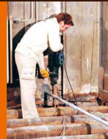
Phase de perçement préalable à la mise en place des tubes d'injection - ici à l'intérieur du bâtiment.
