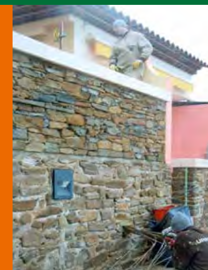
Les injections de résine sous contrôle avec un niveau laser.
