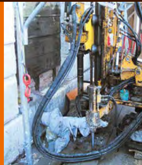
Carottage de reconnaissance descendu jusqu'à 30 m de profondeur.
