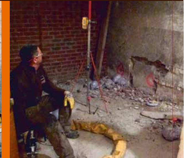
L'injection sous monitoring laser.
