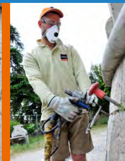
Injections de la résine dans la maçonnerie.
