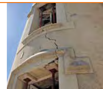
Fissurations sur les façades du château.
