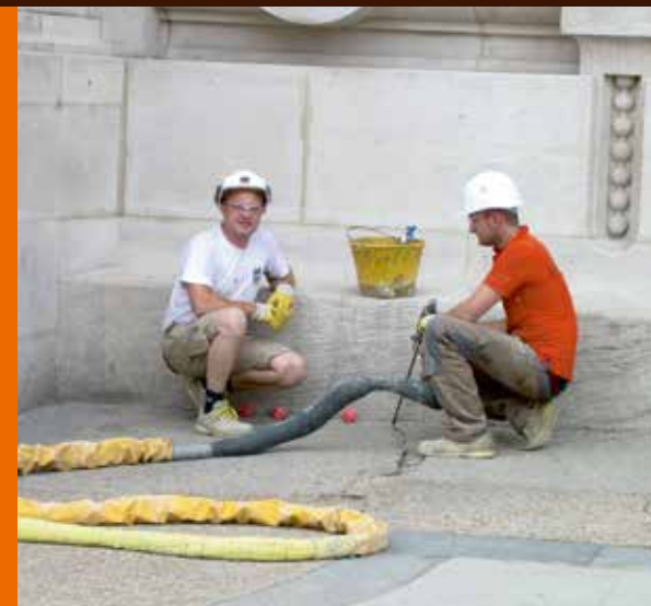
Injection réalisée au pied du bâtiment.
