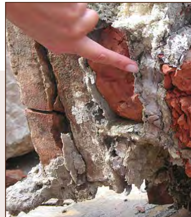
Aperçu du remplissage des vides au sein de la maçonnerie.
