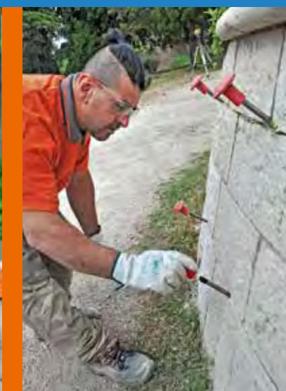
Introduction des tubes d'injection.
