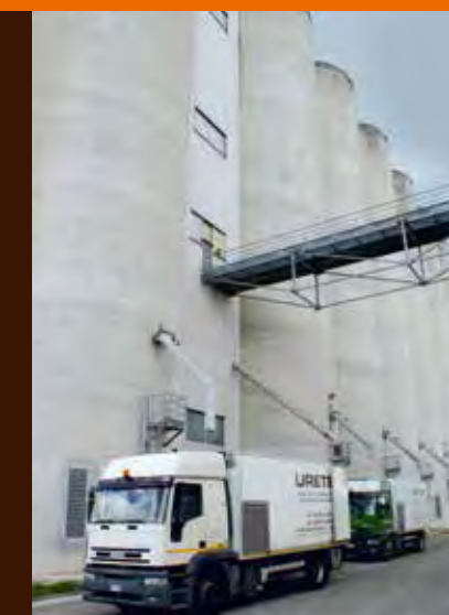
Les camions URETEK® permettant la préparation et l'injection de la résine.
