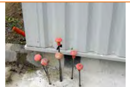
Les tubes d'injections en attente pour traiter un des puits carrés.
