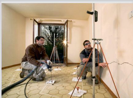
Relevage du dallage
