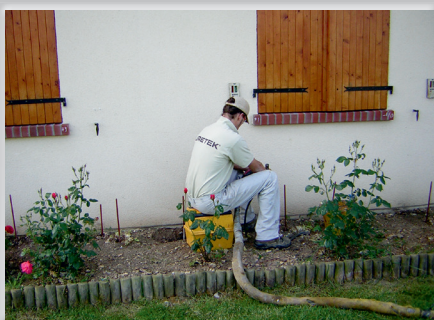
Réalisation d'une injection
