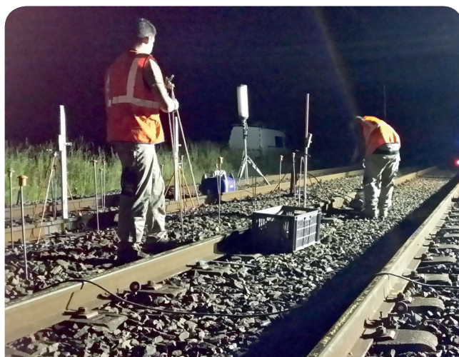
L'installation des niveaux laser pour contrôler les injections en temps réel.
