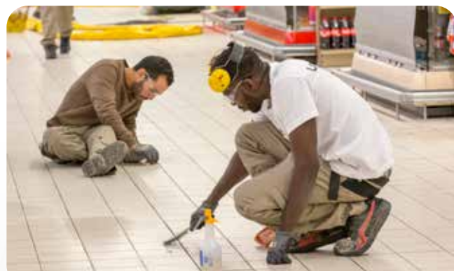
A l'issue des injections, les tubes sont sectionnés et les trous parfaitement rebouchés
