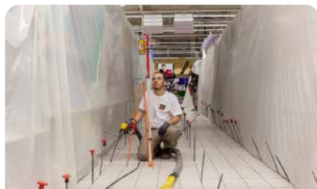
Avant la phase d'injection, les rayons sont protégés par des bâches
