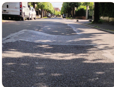
Affaissements et tassements différentiels
