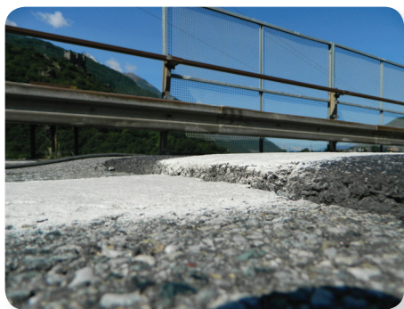
Ruptures de la structure
